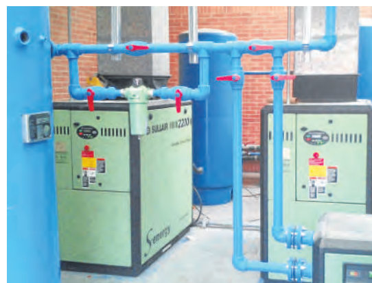
Instalación de Aire Comprimido
