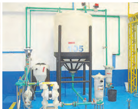
Instalación de Sustancias Químicas (Ácido Peracético)
