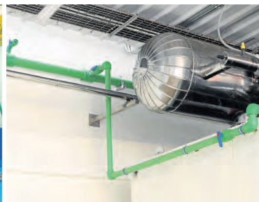
Instalación Red Agua Caliente en Industria
