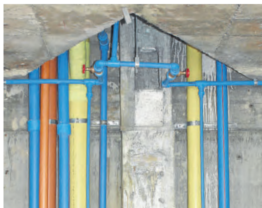
Instalación Red de Agua Potable
