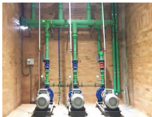
Instalación Sistema de Bombeo Succión y Descarga de Agua Refrigerada
